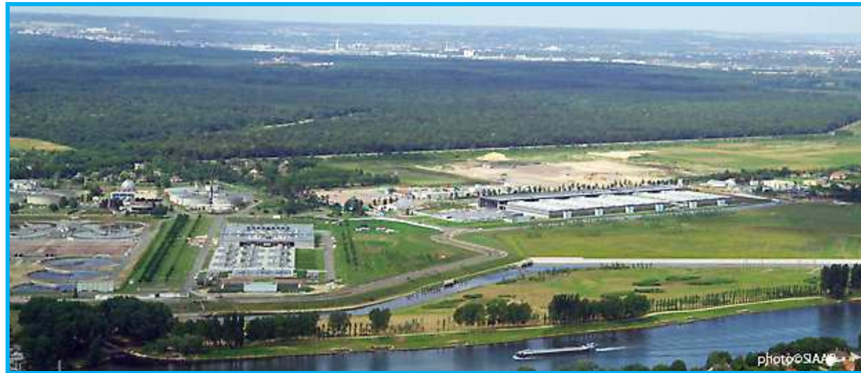
Figure 8 : Vue aérienne de la station depuis la rive droite
